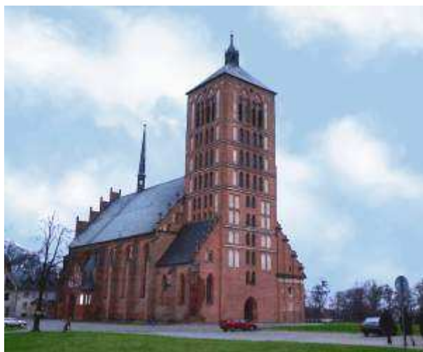
Kościół p.w.św. Katarzyny - gotycki realizowany etapami: 1343-1442, halowy, trójnawowy, sześcioprzęsłowy, założony na planie wydłużonego prostokąta, orientowany
