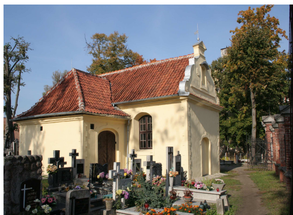
Kaplica Cmentarna p.w.św. Rocha wybudowana w 1711 roku, barokowa, orientalna, dość mocno zniszczona, w trakcie renowacji
